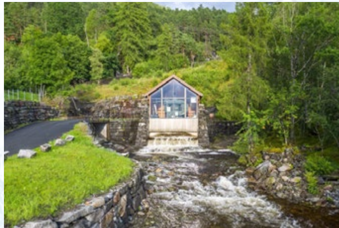
Abb. Kleinwasserkraftwerk Sagres, Portugal
